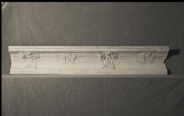
Position: ornamentierte Hohlkehle 23 Bemaßung: H 16cm T 22cm
