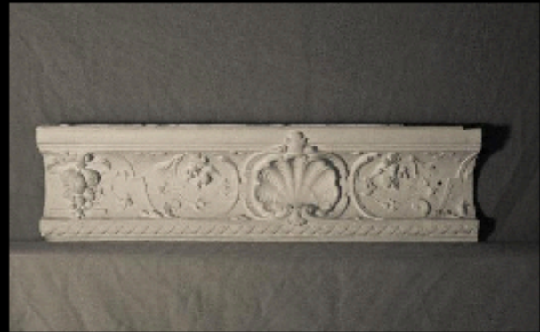
Position: ornamentierte Hohlkehle 004 Bemaßung: H 21cm T 18cm
