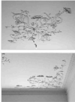
S. 24 Stuckdecke, Villa (Neubau), Neuhausen- Nymphenburg, München.
