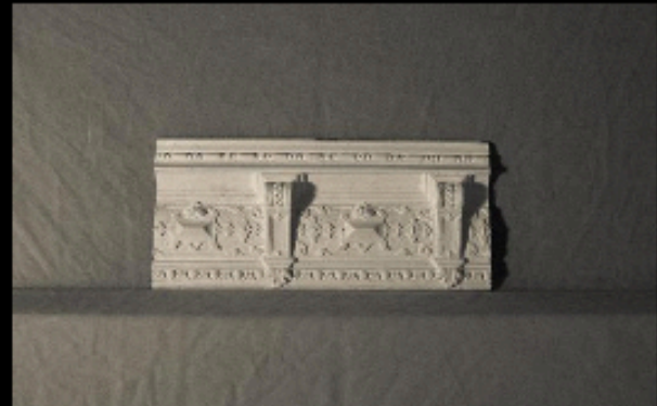
Position: ornamentierte Hohlkehle Ø16 Bemaßung: H 19cm T 19.5cm
