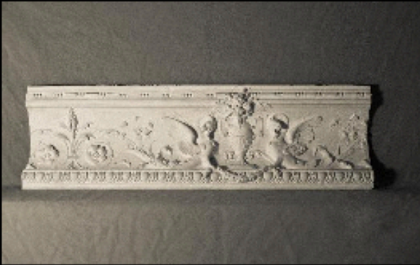
Position: ornamentierte Hohlkehle 001 Bemaßung: H 24.5cm T 22cm
