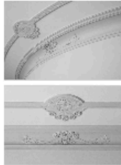
S. 25 Stuckdecke, Villa (Neubau), Neuhausen- Nymphenburg, München.
