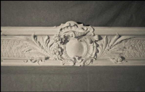
Position: ornamentierte Hohlkehle 027 Bemaßung: H 18cm T 21cm
