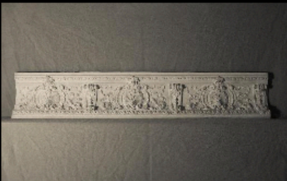
Position: ornamentierte Hohlkehle Ø17 Bemaßung: H 18.5cm T 20cm
