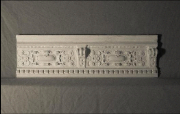
Position: ornamentierte Hohlkehle Ø13 Bemaßung: H 20cm T 23cm
