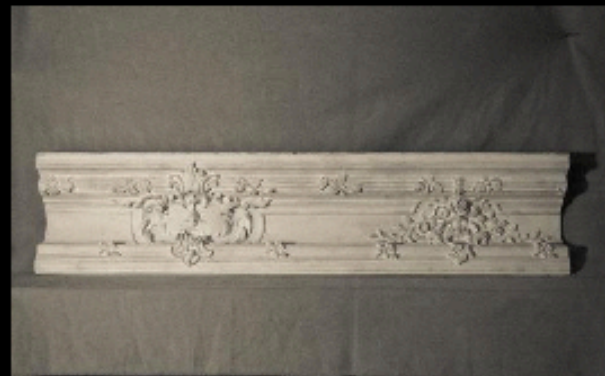
Position: ornamentierte Hohlkehle 030 Bemaßung: H 22cm T 22cm
